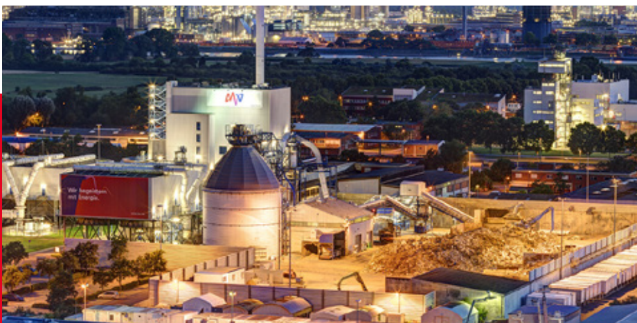
Aus Reststoffen klimaneutral Energie gewinnen: Das Biomasse- kraftwerk von MVV
